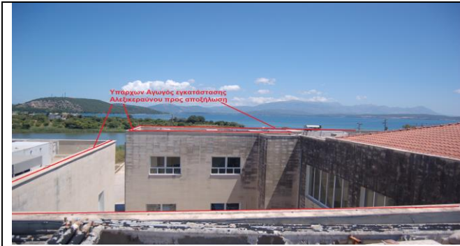
Ενδεικτική φωτογραφία αγωγού συστήματος αντικεραυνικής προστασίας προς αποξήλωση
